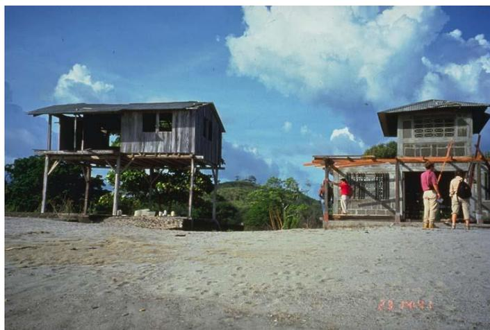
**Construcción contrastada,** el popoyo, Nicaragua. La imagen anterior muestra dos diferentes estructuras que se mantuvieron intactas. **La estructura a la derecha, una estructura rígida, solida.** Luego está la estructura de la casa a la izquierda la cual se eleva del suelo para permitir el paso del agua por abajo. Esta se eleva sobre unos débiles pilotes, que al tener poca superficie de roce, no son derrivados. El primer caso en cambio si tiene mucha
