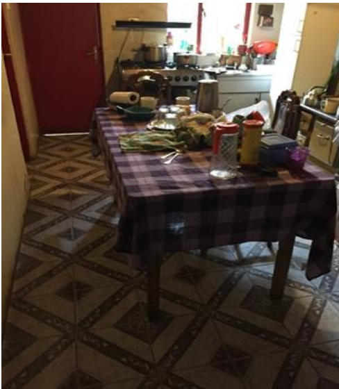
Figura 7 Cocina: el espacio entre la pared y la mesa es estrecha lo mismo sucede hacia el lado de la cocina leña, la puerta no cumple con anchura.
