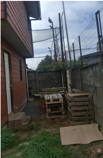
Figura 12 Patio trasero se observa como el equipamiento no permite una correcta ruta accesible.
