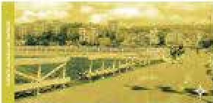
ÁREA DE RECREACIÓN CALLE DE LA VIGILANCIA
