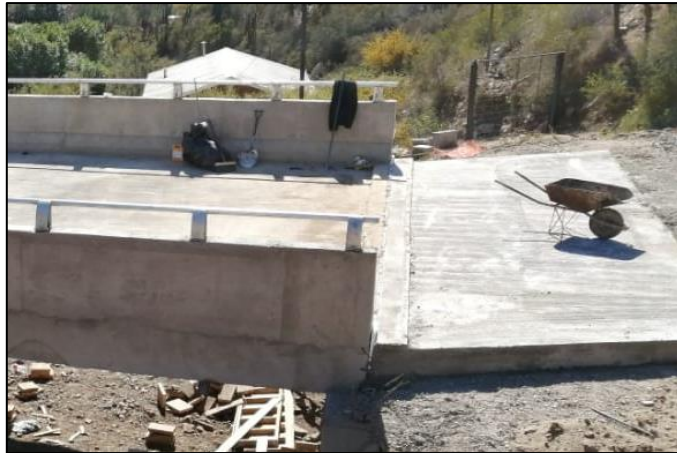
Figura 2.2.3 Losa de Acceso
