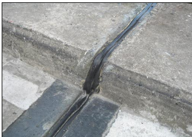
Figura 2.2.5 Juntas de dilatación
