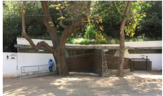
Fig. 46 Baños del parque. Fuente: Elaboración propia
